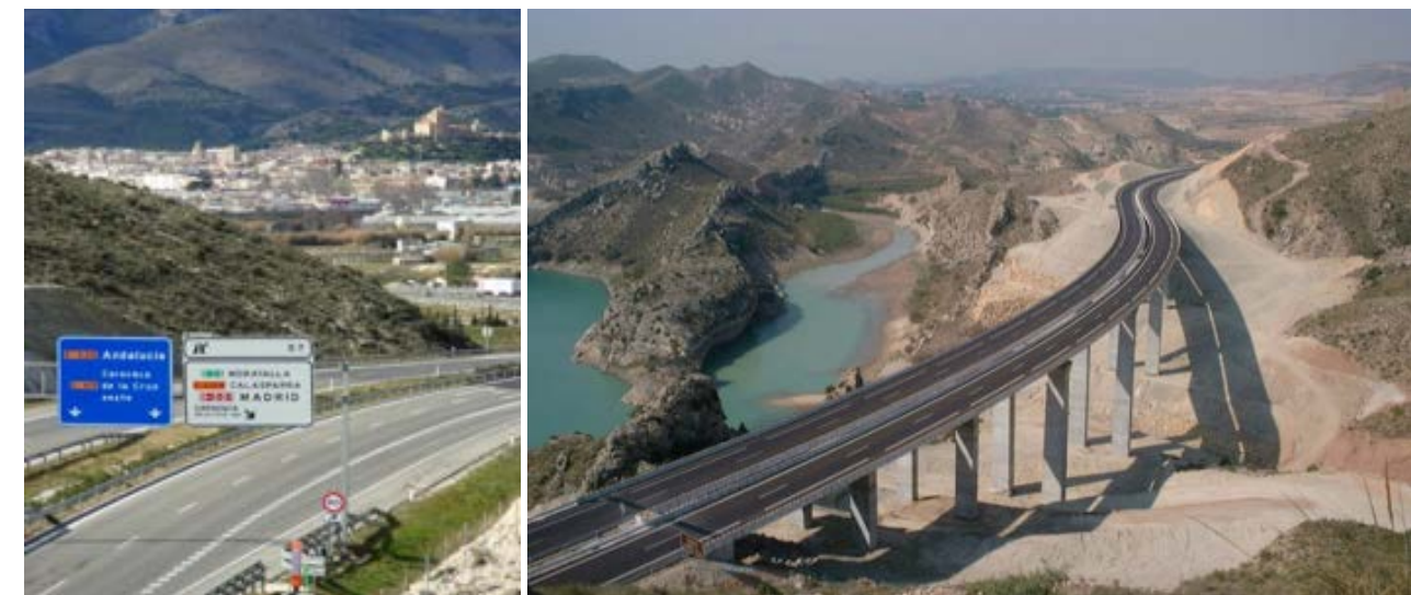
Figura 17. Perspectiva visual del enlace sur de Caravaca de la Cruz y el viaducto del embalse de la Cierva.
