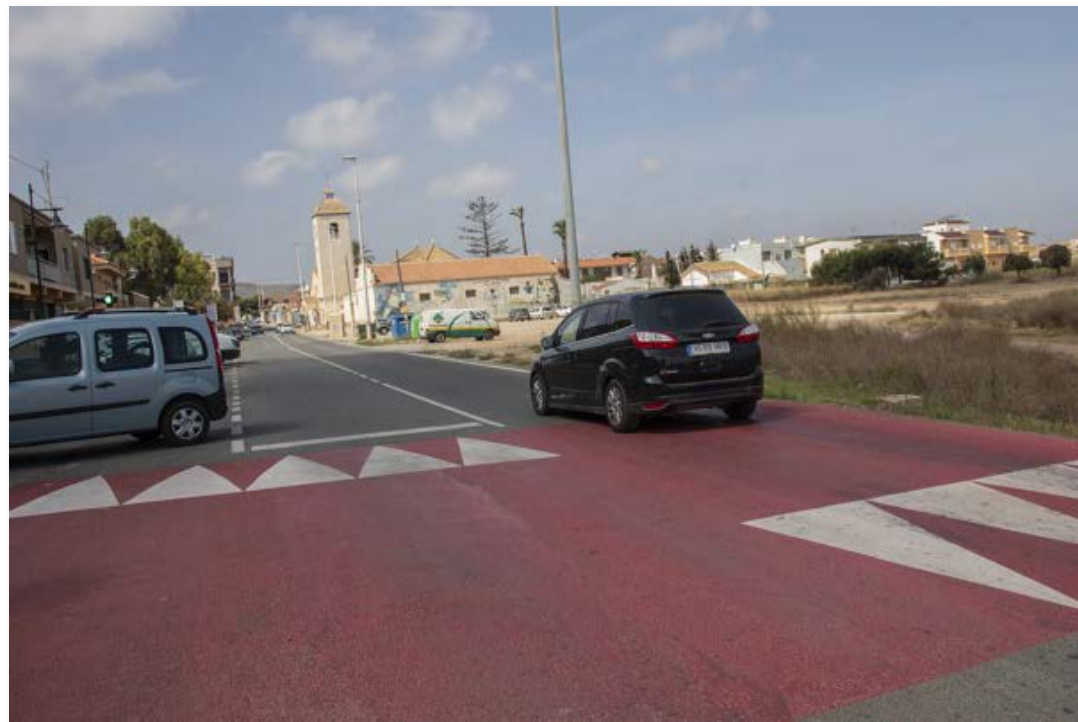
Figura 123. Ejemplo de Resaltos de lomo y almohada señalizados con pintura en color en las interurbanas.
